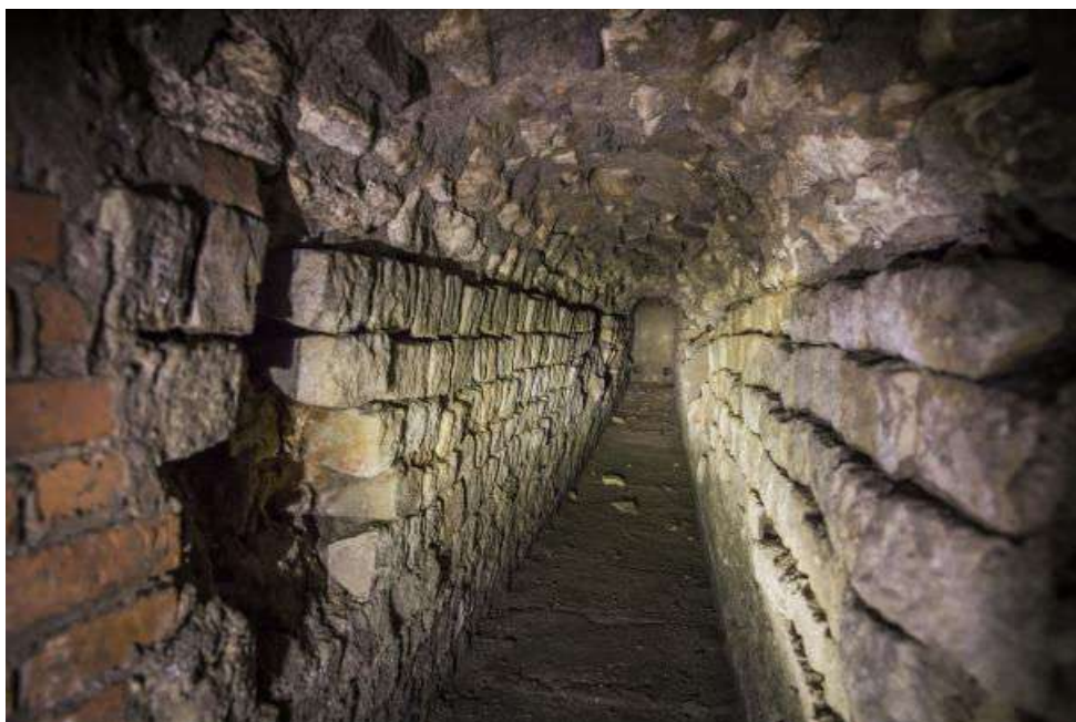
Una vieja alcantarilla del GòticLlibert Teixido
