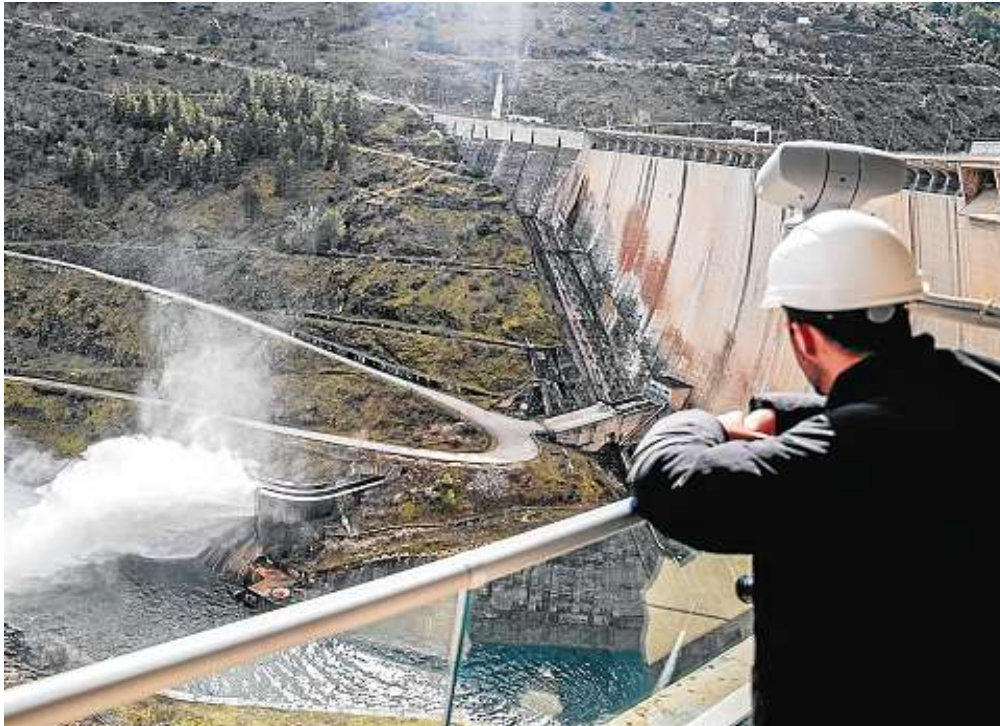
Presa del Atazar, la mayor infraestructura de la región, desembalsando agua, ayer. Tania Sileira
