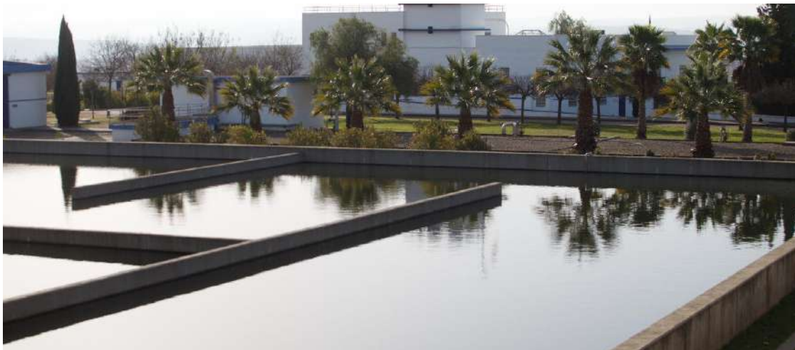
Instalaciones de Emacsa
